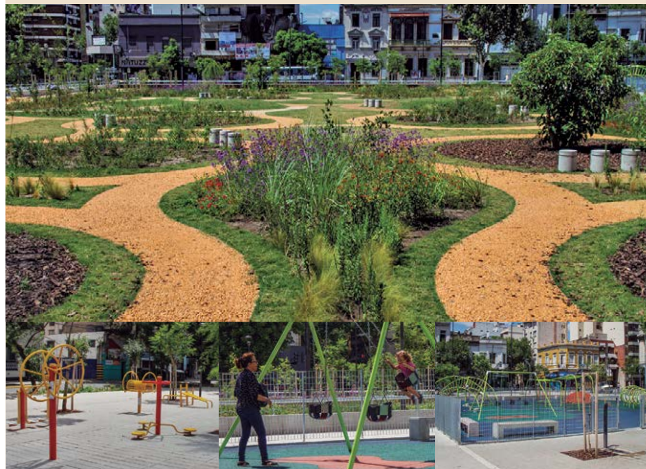
Obra Manzana 66. Av Jujuy y Av. Belgrano
